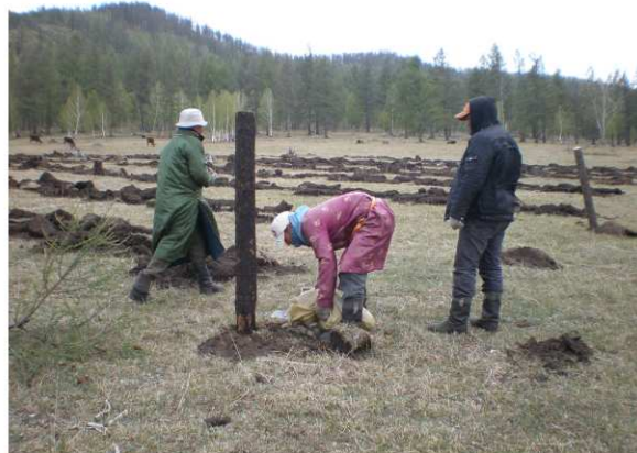
写真 4. 家畜防護柵設置
